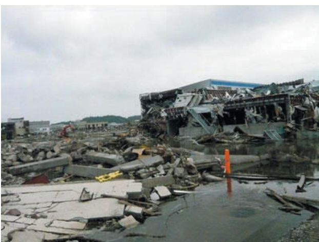
津波で破壊された工場
