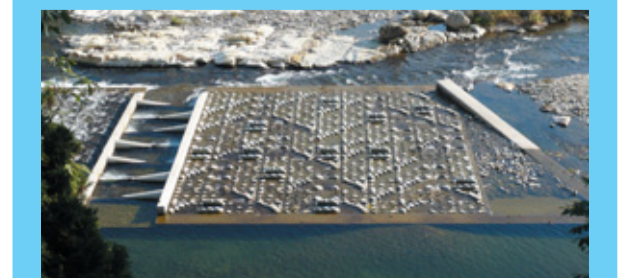
長沢地区魚道
